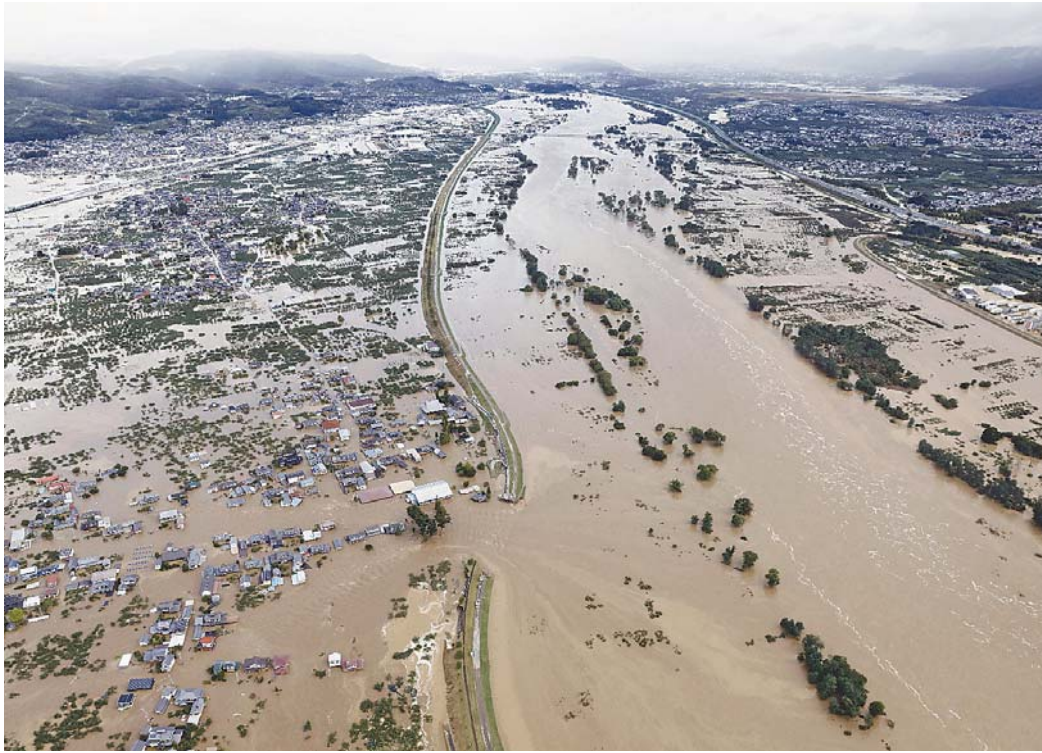
台風19号による大雨で増水し氾濫した千曲川。中央左は決壊した堤防＝13日午前8時15分、長野市穂保（共同通信社ヘリから）
